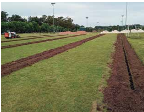
TRINCHERAS PARA TUBOS DE DRENAJE – CANCHA DE BABY FÚTBOL
