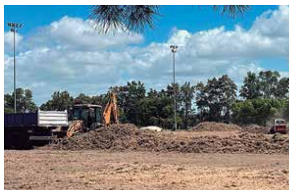
ROTURADO CANCHA N°2 – TRABAJOS PRELIMINARES PARA CORRECCIÓN DE DESNIVELES
